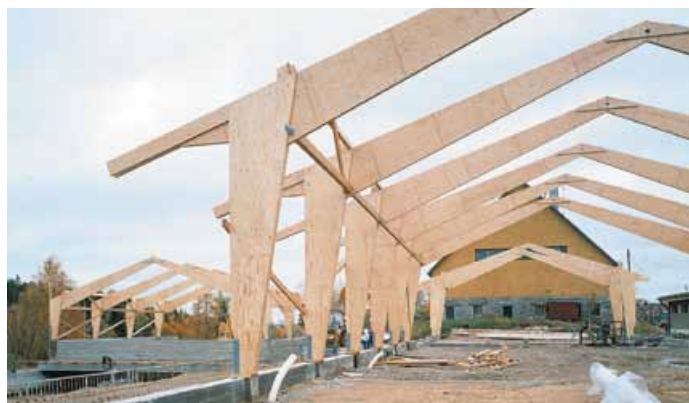
Здания с большими пролетами легко монтируются из балок Керто, изготавливаемых согласно проекту
